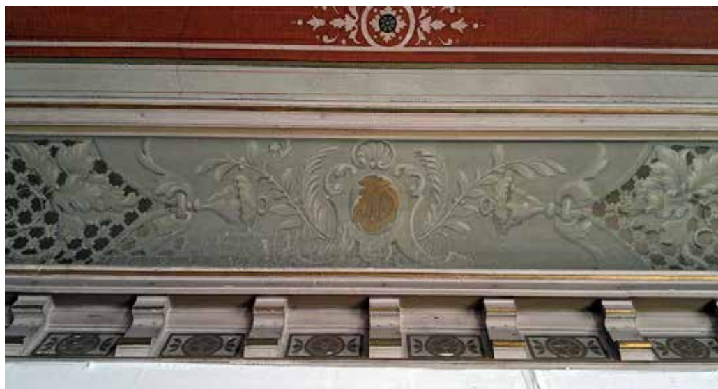
Kivekkäiden aikaisen salin koristekattoa, jossa keskellä ylimaalattuina erottuvat Aalbergin ja Kivekkään nimikirjaimet. Edellisen sivun kuvassa kaunista imitaatiomaalausta paneelissa. Livady
