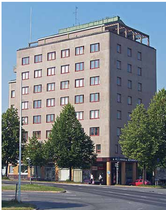
Puiston itäkärjessä on Paasikiven aukio, joka muodostaa liikenteellisesti ja kaupunkikuvallisesti merkittävän tilan. Risteysalueella, Felmanninpuiston puolella, ovat arkkitehti Unto Ojasen suunnittelema Pellonkulma ja arkkitehti Jalmari Lankisen suunnittelema Suojalinna (kuvassa). Yhdeksänkerroksiset asuin- ja liiketilat, jotka muodostavat Paasikivenkadun päähen porttimaisen kokonaisuuden. Liikenteenjakajan äärellä on lisäksi Heikki ja Kaija Sirénin suunnittelema konserttitalo. Kuva: Museovirasto
